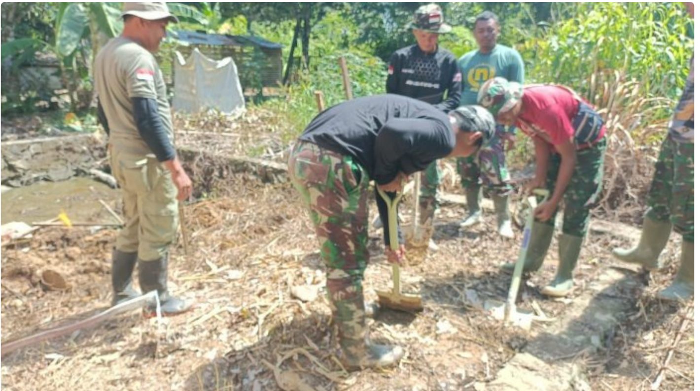
Sasaran Tambahan TMMD Ke-118 Wiltas Kodim 0910/Malinau Mulai di Kerjakan
