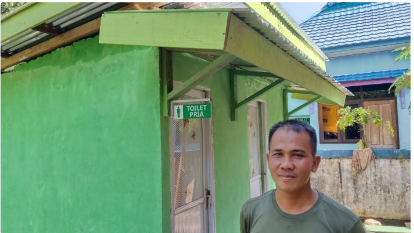
Pembangunan MCK Gereja Selesai 100 Persen, Pendeta Ucapkan Terima Kasih Satgas TMMD
