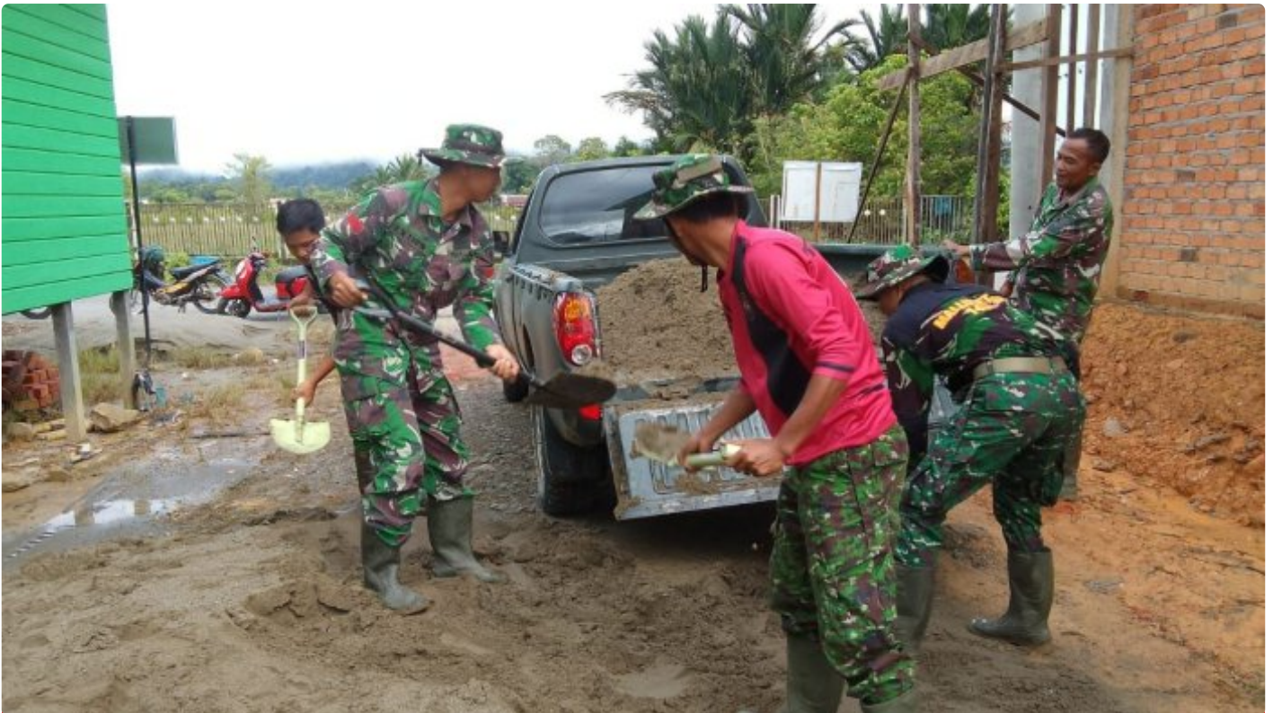
Gunakan Mobil Dinas, Satgas TMMMD 118 Langsir Pasir Di Sasaran Semenisasi Jalan
