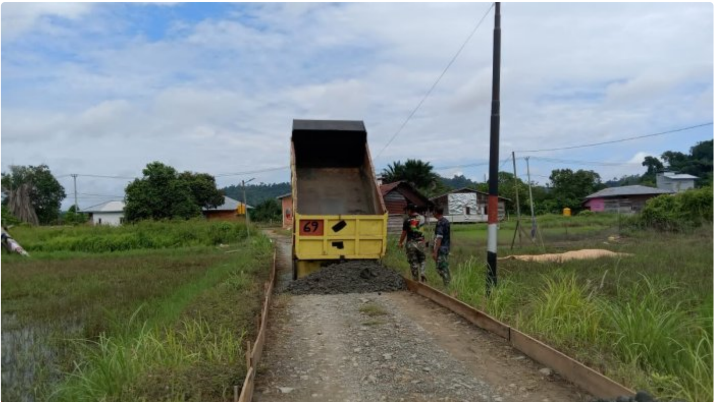
Dorongan Material Tanpa Putus, TMMD Ke- 118 Target Selesai Sebelum Penutupan
